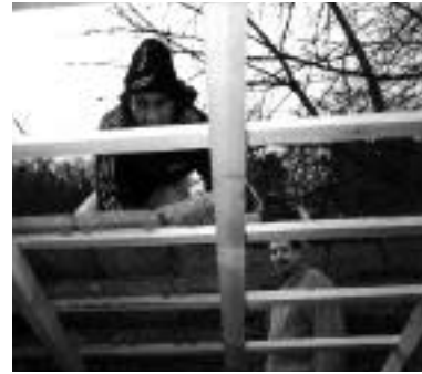
Charpente et couverture réalisées par la Régie déodatienne
