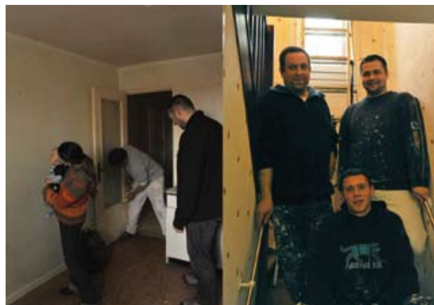
Toute la famille au travail, et l'équipe encadrante de la Régie, sur un chantier en cours et un chantier fini.
